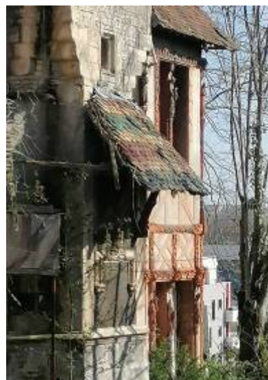
Figure 17 - Vue de la façade : tuiles vernissées, faux pans de bois
