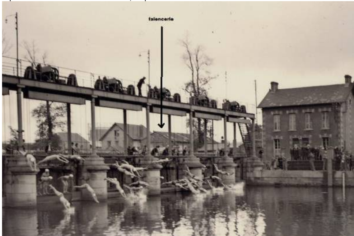
Figure 212 - vue lointaine de la faïencerie (collection particulière)
