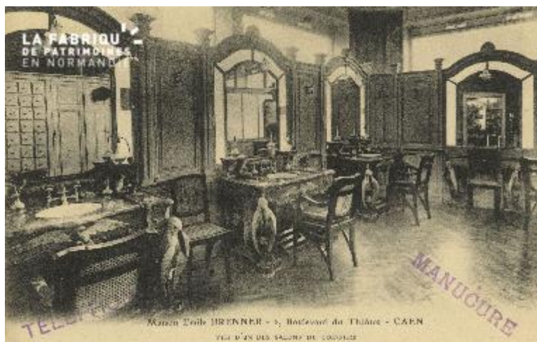
Figure 13 - Intérieur du salon de coiffure Brenner (collection La Fabrique de Patrimoines en Normandie)
