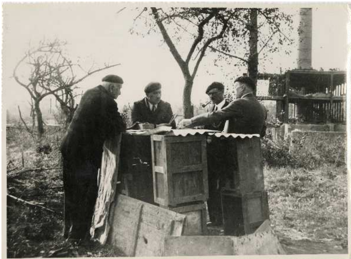
Figure 38 - de gauche à droite : Louis Bérard, Christian Bérard, Félix Chéron ingénieur céramiste, André Nussbaumer, constructeur de matériel céramiste – Examen des dégâts et projet de la nouvelle installation
