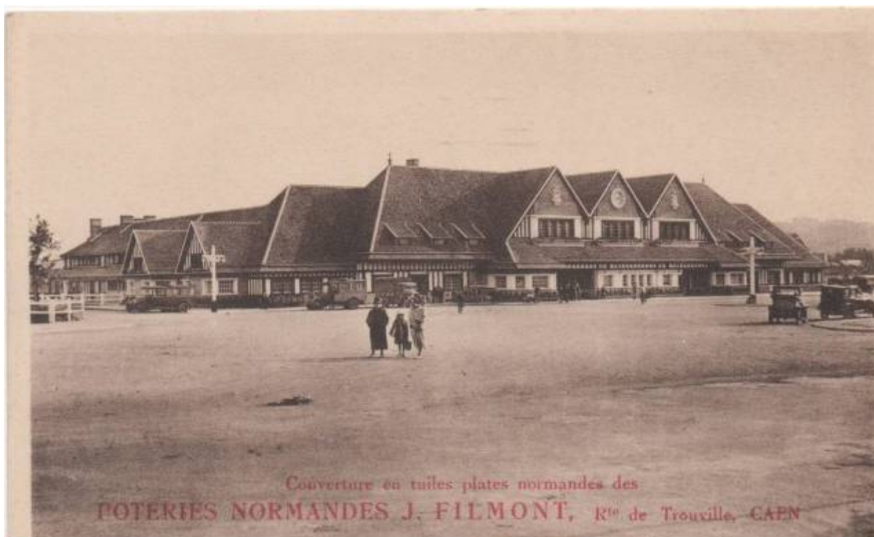
Figure 99 - Couverture de la toiture de la gare de Trouville Deauville
