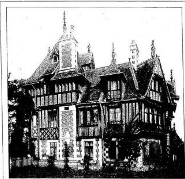
VUE D'ENSEMBLE D'UNE VILLA NORMANDE. — Foucault abstraction de la trop grande diversité d'ornementation des façades qui lui eût imposé ou sa décoloration ; c'est le dessinateur personnel du Directeur de la Manufacture de Nancy, il se dégage de cette Villa une impression de légèreté de toiture résultant uniquement du jeu subtil des Poinçons, Èpis et faîtages ornés.
