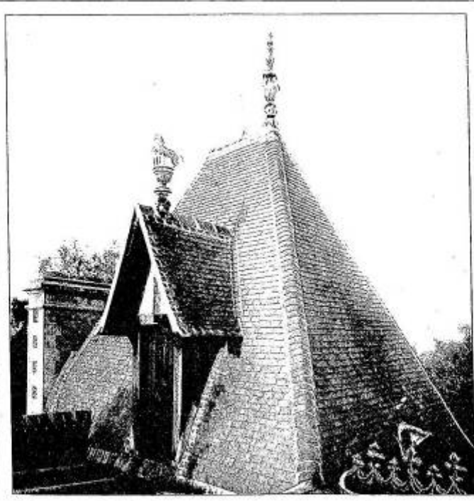
UN CORM DE TOITURE. — Nous trouvons répartis dans ce coin de toiture toutes les dispositions ornementales à savoir : sur la partie gauche, un épi de croquet, sur la lucarne, au-dessus du pignon, sur la crête de droite, un faitage à décor appliqué. (ÉL. EN 4 de Compost)
