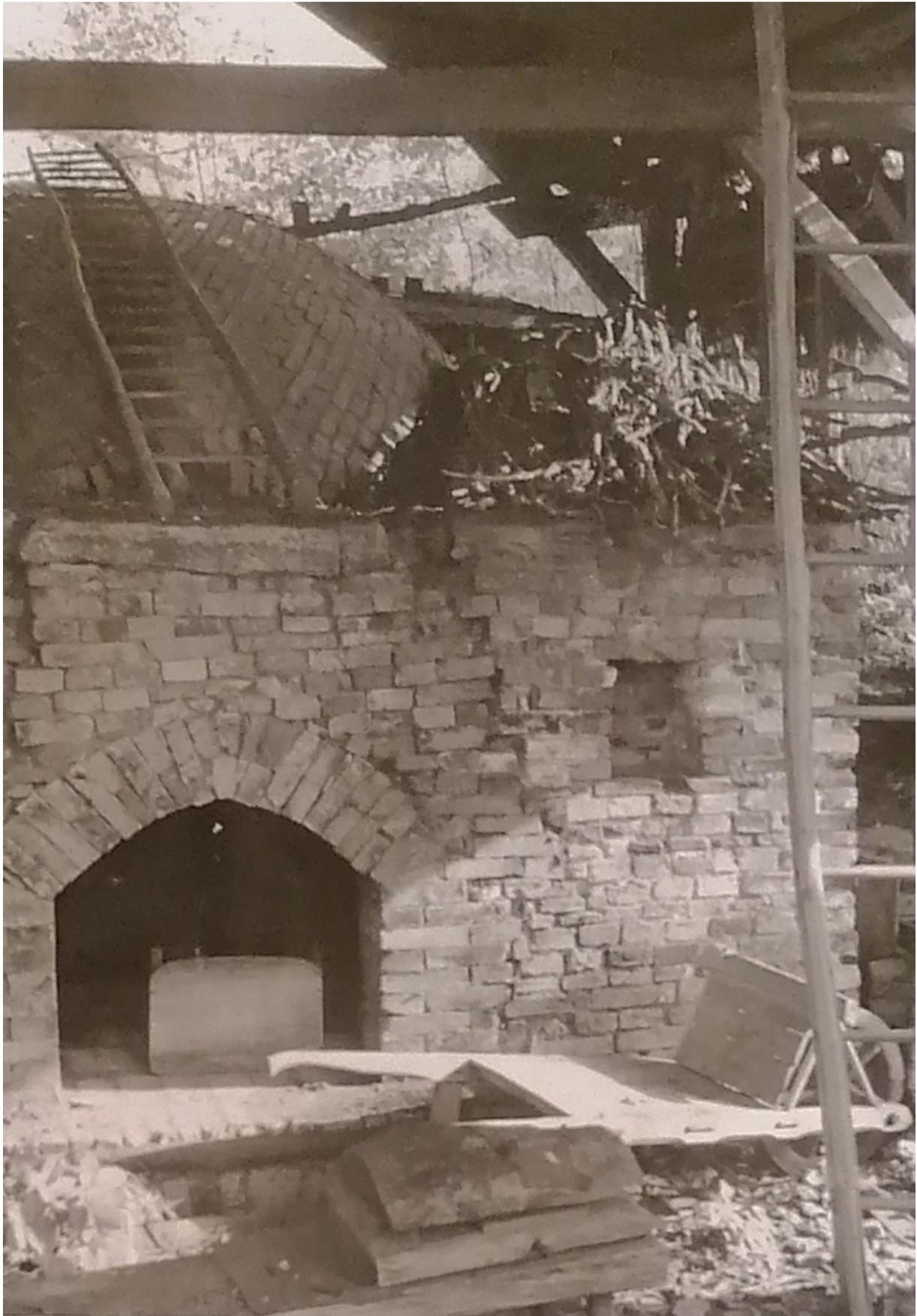
**Figure 107 - Entreprise Pellet : Four : côté foyer, gueule de foyer, cendrier, voûte**
