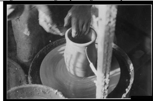
Figure 27 - Enflage et polissage à l'estèque 03
