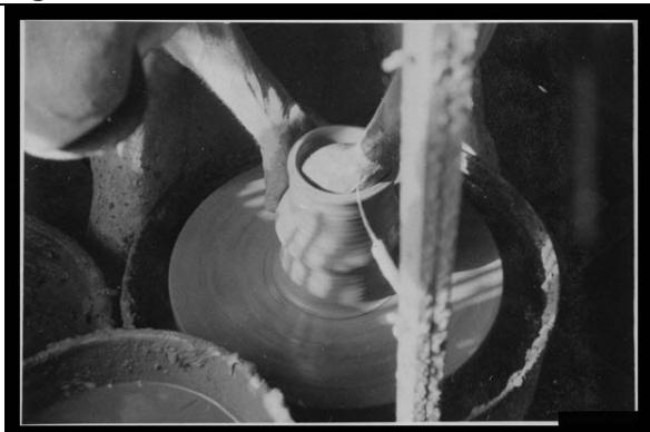
Figure 32 - Enflage et polissage à l'estèque 1
