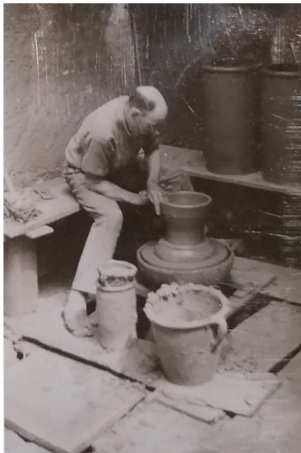
**Figure 68 - Fabrication d'un mahon : la partie supérieure 'greffe du mahon' est formée**
