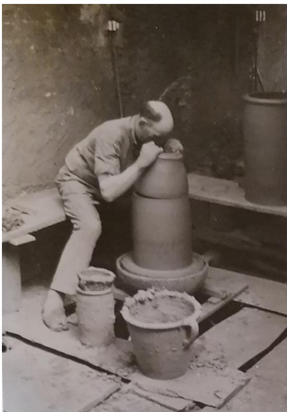
**Figure 73 - Fabrication d'un mahon : mise en place de la 'greffe' sur le 'pied' par Léon Bihel**
