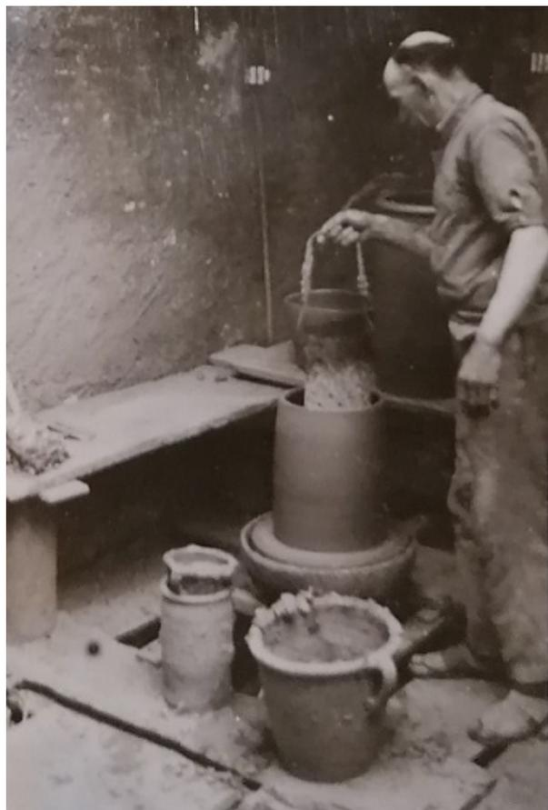
**Figure 72 - Fabrication d'un mahon : séchage à la chaufferette du pied du mahon**
