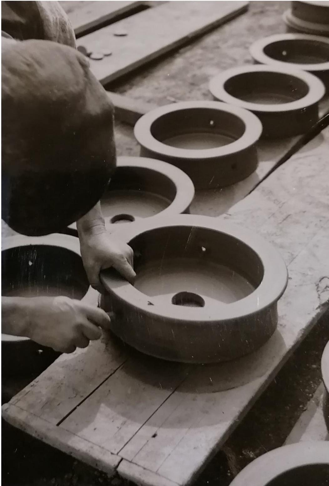
Figure 91 - enfouneurs perforés par un manoeuvre
