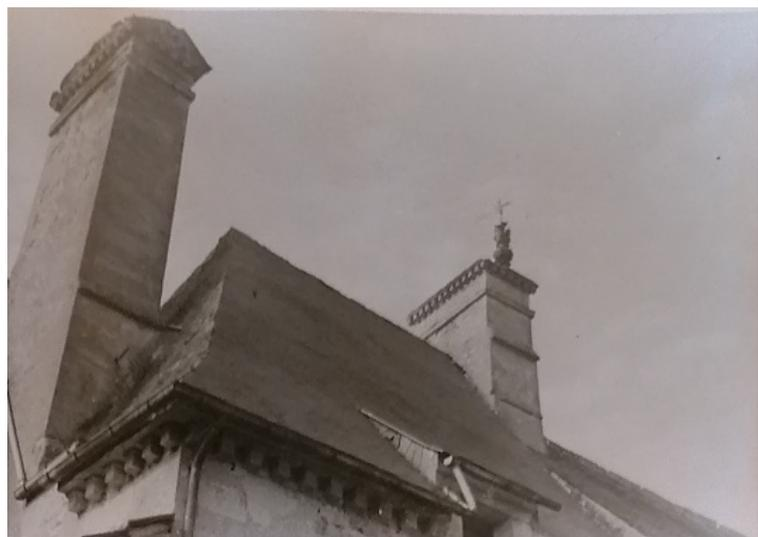
Figure 102 - détail de l'épi de faîtage Ferme manoir route de la belle épine
